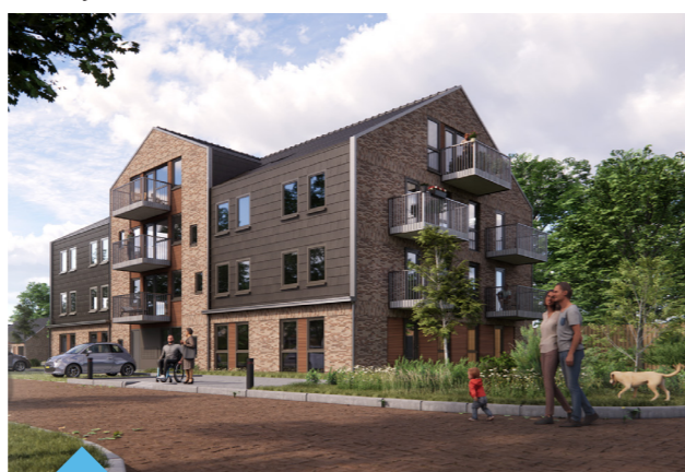
Bakkerserf 30 woningen & appartementen De bouw is begonnen
