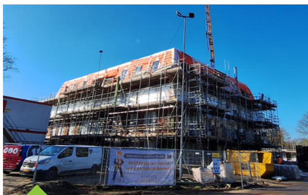
Ooststreek 30 appartementen Hoogste punt is bereikt
